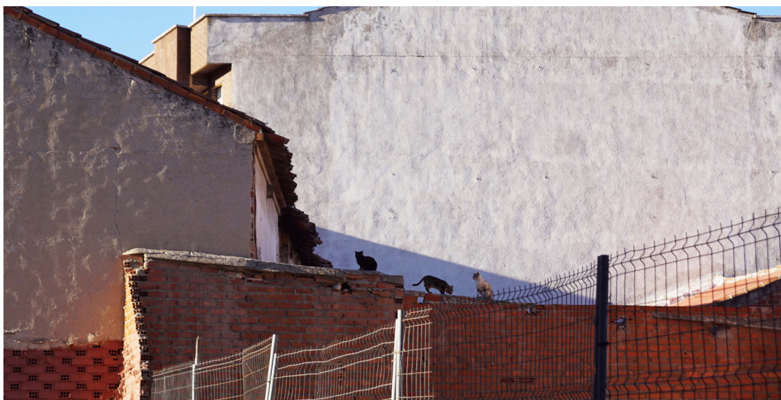
Estado actual de uno de los ámbitos de actuación en el casco
